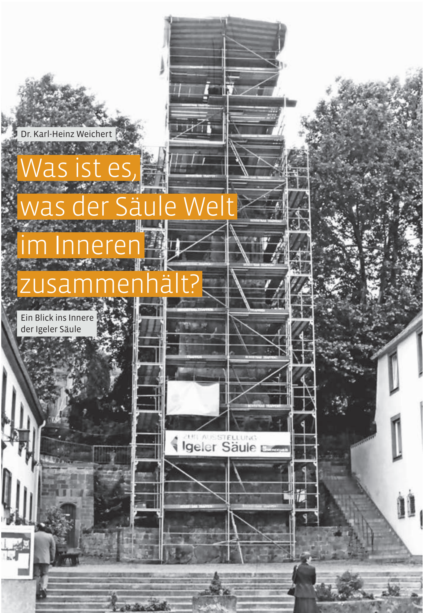
Die Igeler Säule, eingerüstet während der Renovierungsarbeiten
