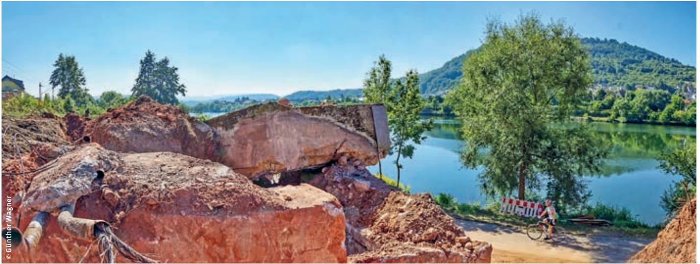
← Die Reste des Bunkers WH 12812 während der Abrissarbeiten im Zuge des Bahnbaus. ↑
