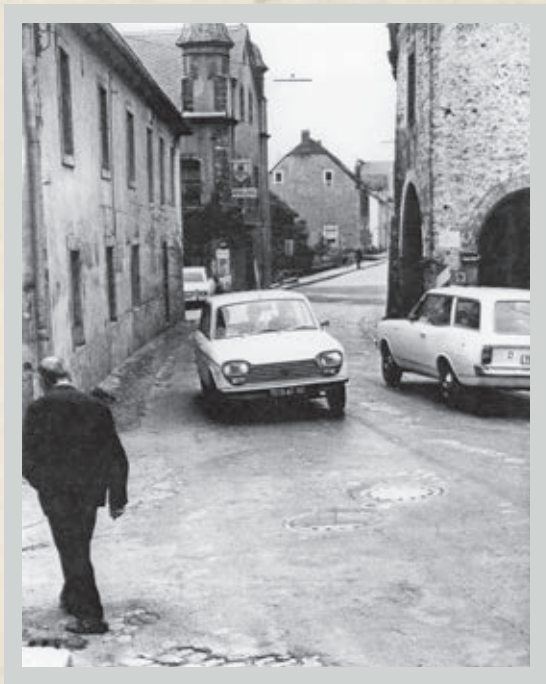
Hier sieht man einen Engpass, welcher durch < die Verbreiterung der B 49 beseitigt wurde.
