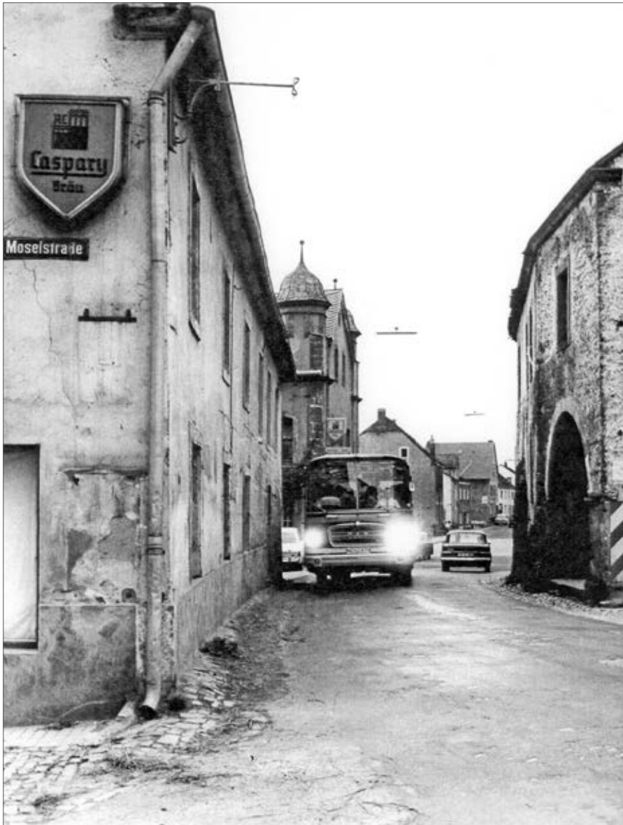
© Engpass B49 vor dem Ausbau
